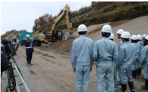
▲▲ 土砂積込状況の現場見学の様子
