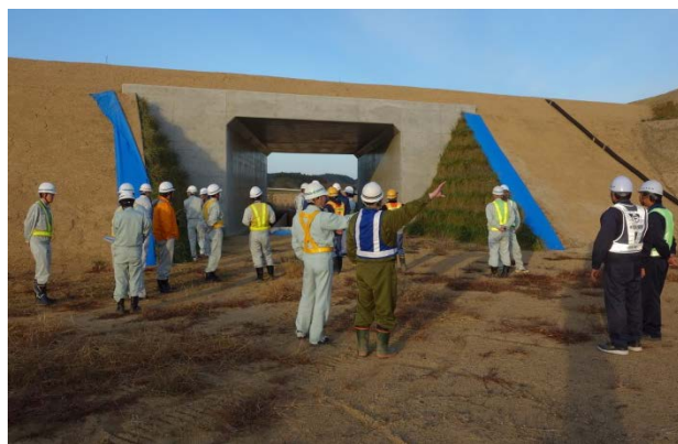
函渠工(七戸町字榎林中田地区) 現場見学の様子
