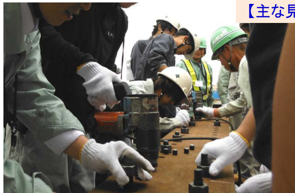
写真：ボルトの締め付け作業体験状況
