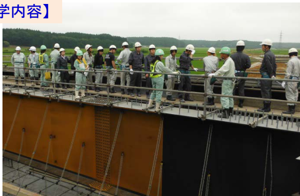
写真：砂土路川橋での現場見学状況
