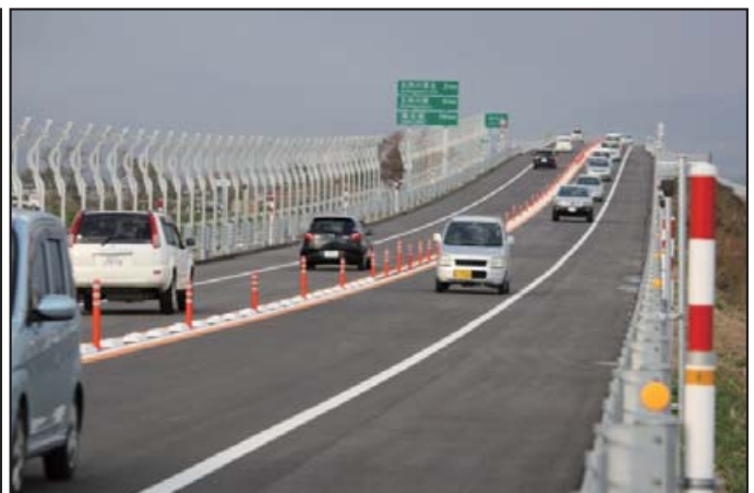
▲一般開放(15:15~)後の状況
