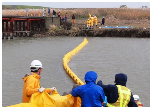
オイルフェンス設置状況(岩木川水系での様子)
