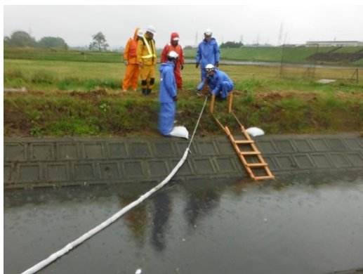
吸着フェンス設置状況(馬淵川水系での様子)
