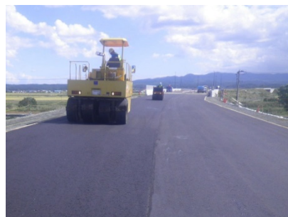
舗装工事の様子
