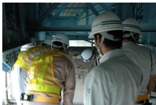
▲橋脚のひび割れを計測
