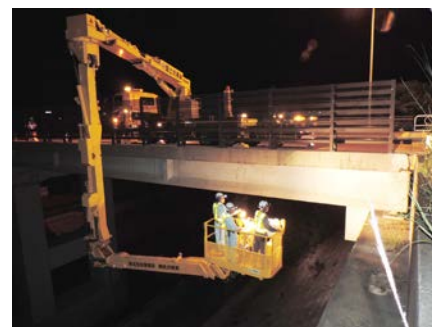
▲橋梁点検の一例
