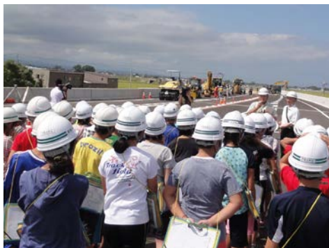
工事現場で説明を受けている様子
