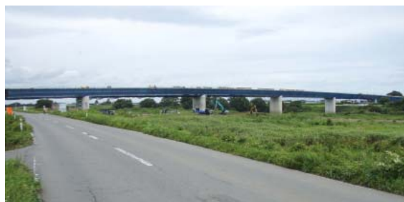
岩木川橋の架設状況
