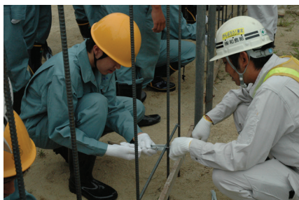
鉄筋の組立作業の様子①
