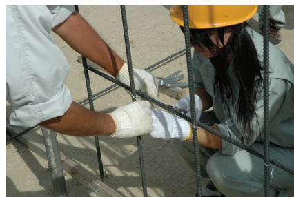
鉄筋の組立作業の様子②
