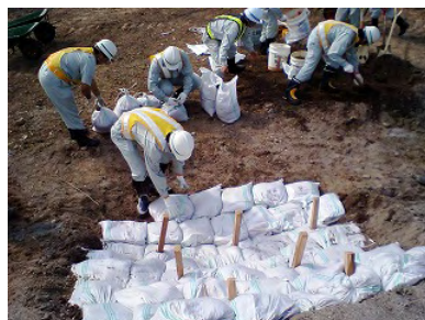
職員は機械無しで人の力のみ 測量と記録、小型の土のうを積んで被害が拡大しないようシートで保護
