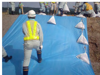
職員は機械無しで人の力のみ 測量と記録、小型の土のうを積んで被害が拡大しないようシートで保護
