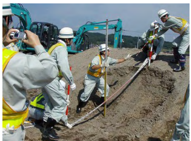
職員は機械無しで人の力のみ 測量と記録、小型の土のうを積んで被害が拡大しないようシートで保護
