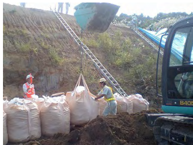
協力会社の皆さんは、さすがの手際の良さ 左からフロンカゴ積み、大型土のう積み、板柵工
