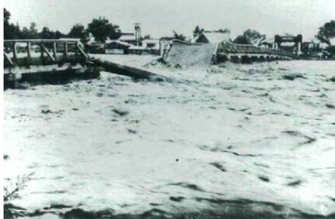
昭和33年8月洪水 岩木橋崩落(岩木川)
