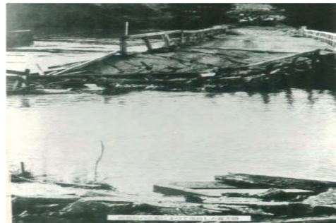
昭和33年8月洪水 剣吉橋崩落(馬淵川)
