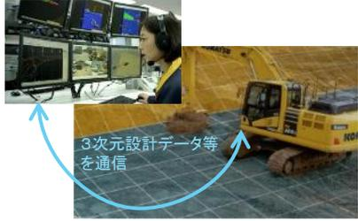
3次元設計データ等により、ICT建設機械を自動制御し、建設現場のIoT(\*)を実施。
