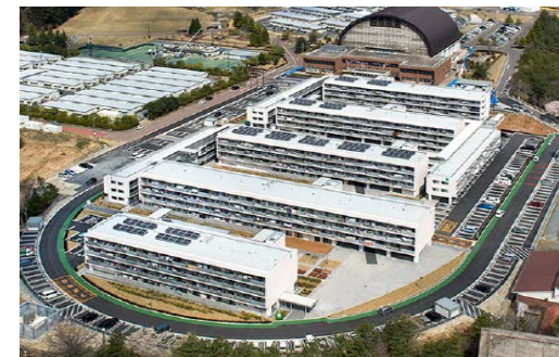
女川町・陸上競技場跡地地区200戸 (H26.3完成) 競技場の活用によりスピード竣工
