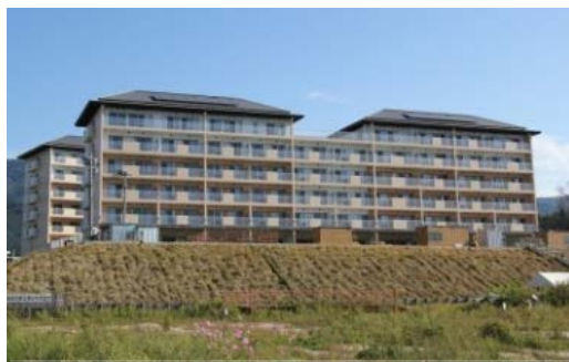
陸前高田市・下和野地区120戸 (H26.9完成) 試験盛土により早期着手
