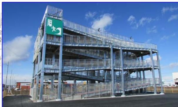
平成27年2月に市内第1号となる避難タワーが完成しました。鉄骨2階建て、6m以上の高さに約300人が避難できるスペースを設け、津波に対応するための強度を有しています。また、寒さ対策のための居室空間の設置、車椅子やベビーカーに配慮したスロープなど、独自の工夫を反映したつくりとなっています。内部には発電機等の備品や非常食等を備えています。
