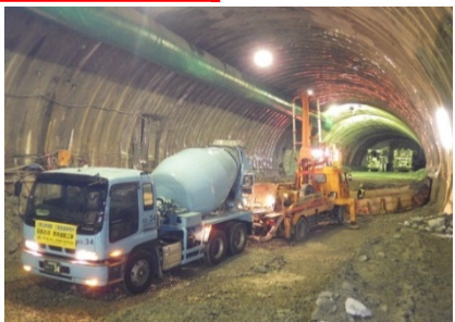
トンネル工事への本格的出荷状況(宮古地区)
