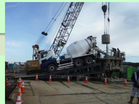
コンクリート打設状況
