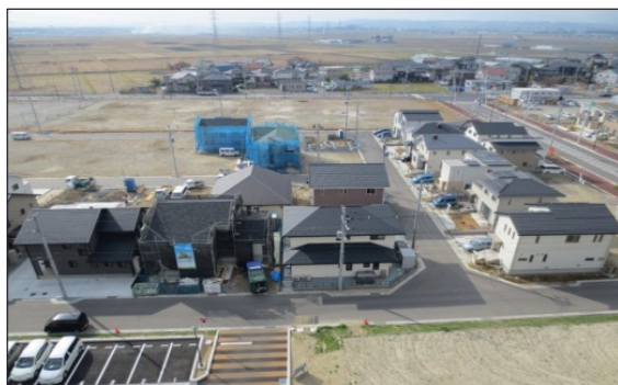
住宅建設が進む荒井東地区(H26.11撮影)
