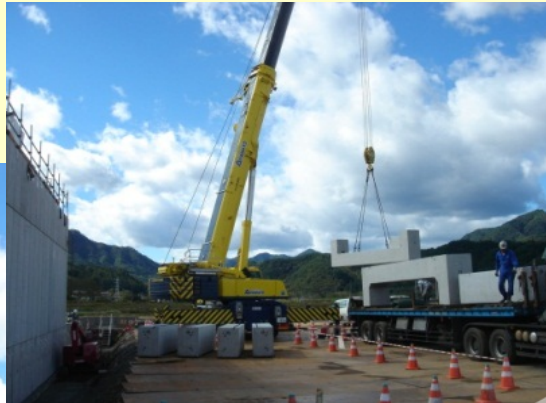
プレキャストBOXの搬入・据付状況
