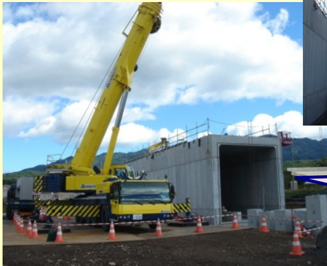
プレキャストBOXの搬入・据付状況
