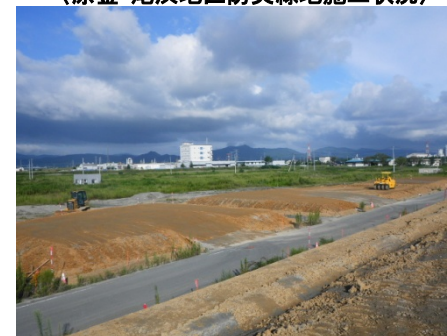
〈原釜・尾浜地区防災緑地施工状況〉
