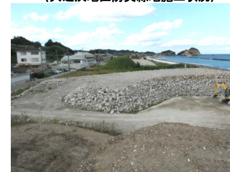
〈久之浜地区防災緑地施工状況〉
