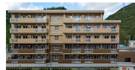
釜石市野田団地（32戸） H25. 11月完成
