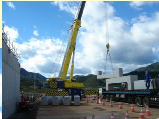
通常、現場打ちコンクリートで施工する、内空断面が4m<sup>2</sup>程度以上の大型のBOXカルバートをプレキャストコンクリート製品に転換。
