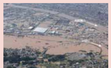
令和元年10月台風第19号(東日本台風) 福島県郡山市 阿武隈川(国管理)
