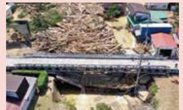
令和3年8月温帯低気圧による豪雨 青森県むつ市 小赤川(県管理)
