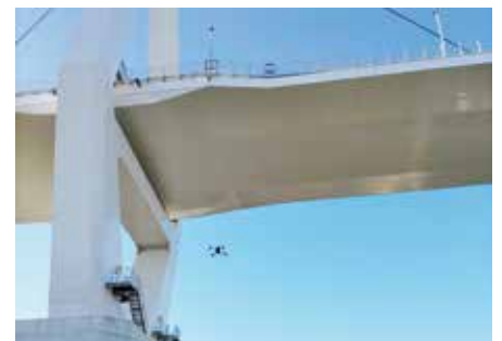
ドローンによる橋梁点検
