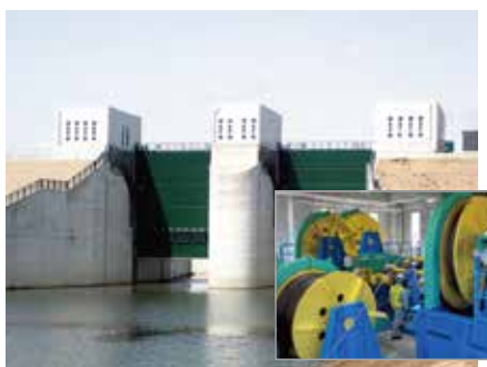
水門ゲート設備
