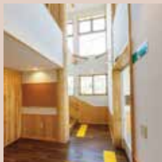
CLT材。ヒバ丸太を利用したホール
