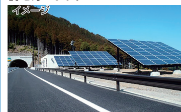
太陽光発電設備
