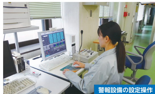
警報設備の設定操作
