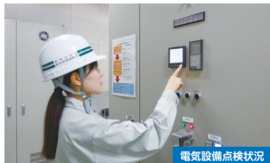
電気設備点検状況
