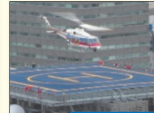
屋上ヘリポート
