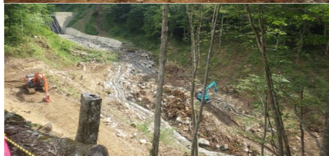
赤倉沢第1砂防堰堤
