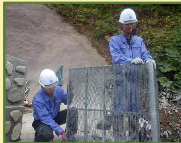
型枠設置作業の様子
