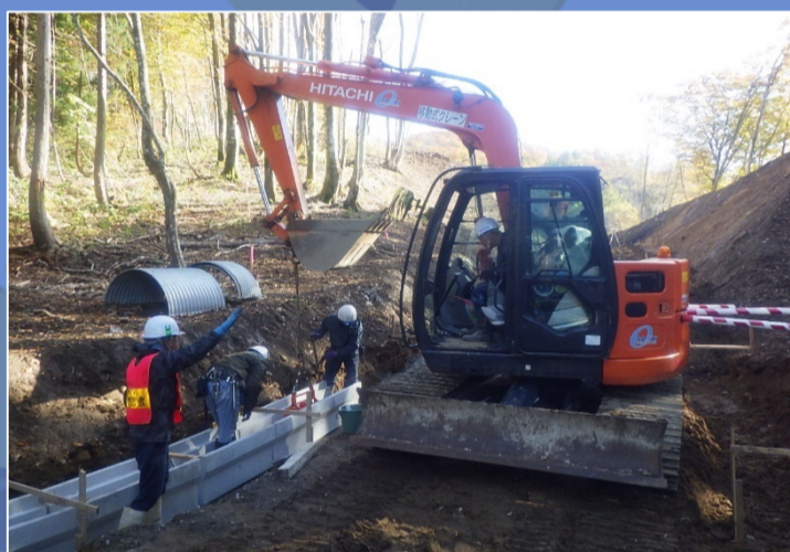
側溝の設置作業
