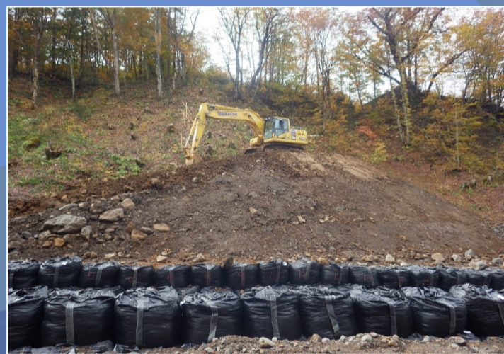
重機足場の造成作業
