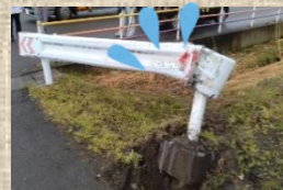
←↓交通事故で損傷した道路付属物
