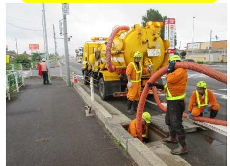
写真は、側溝清掃車による作業の様子です。
