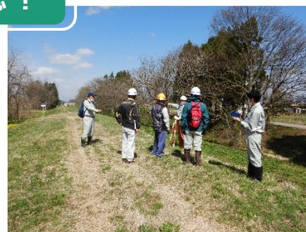
堤防徒歩点検は年に2度、出水期前の春と、出水が落ち着いた秋に実施しています。入梅や台風による洪水に備え、普段行っているパトロール車を用いた巡視で確認できないような箇所を歩きながら点検を行います。
