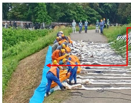
青いシートまで水位が上昇していることを想定し、排水ポンプ車の配置や操作が迅速かつ的確に作業を行えるよう確認しながら排水している様子
