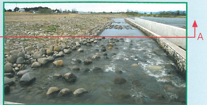
改築後の大久保堰 (H18.3完成) の左岸魚道状況
