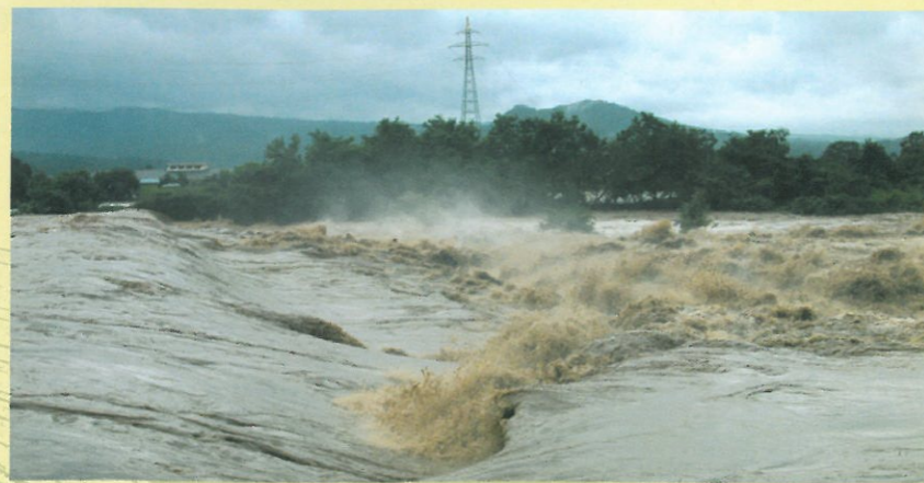
幡野弁天頭首工(堰の影響による激流状況)
