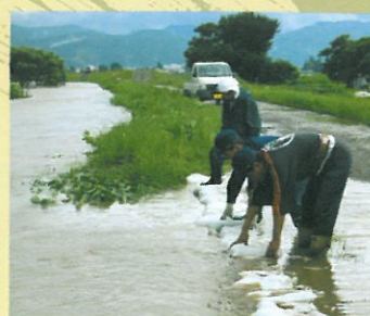
柳田橋付近(水位上昇による水防活動状況)
