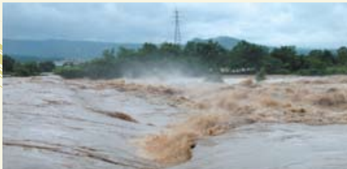
幡野弁天頭首工(堰の影響による激流状況)
