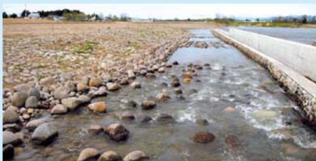
大久保堰の左岸魚道
