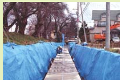
導水路設置状況
