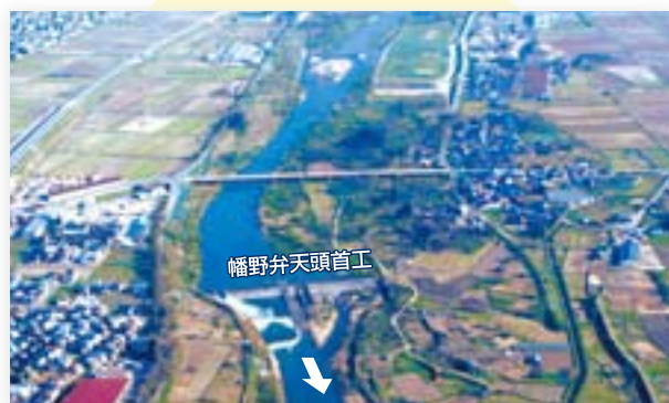
幡野弁天頭首工
