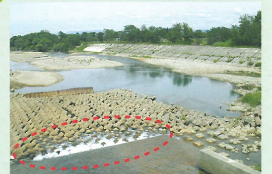
河床低下により、魚道入口の落差が大きく魚類は迷走している。
