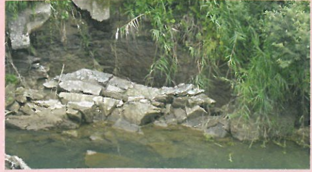
粘土が露出し、河床の礫が減少している。
