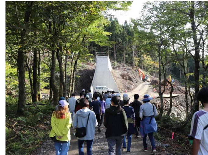
水沢砂防堰堤工事現場の見学
