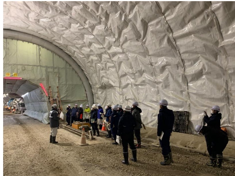
▲横堀トンネル内見学状況
