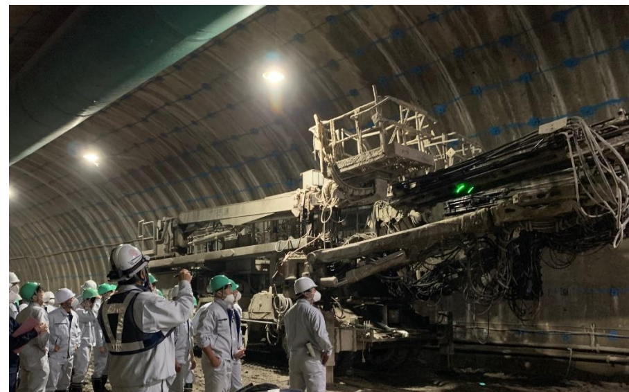
▲横堀トンネル内見学状況
