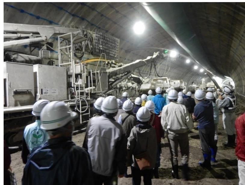
▲横堀トンネル内見学状況
