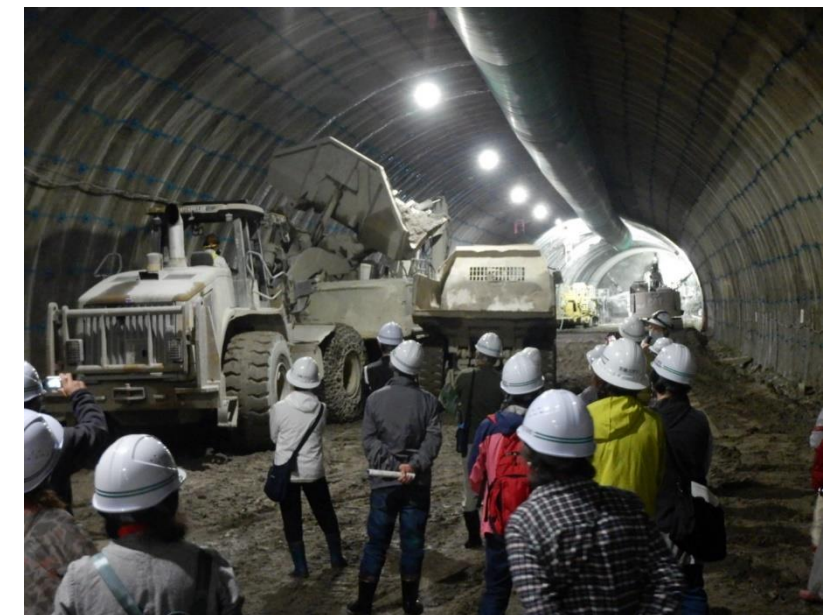
▲横堀トンネル内見学状況
