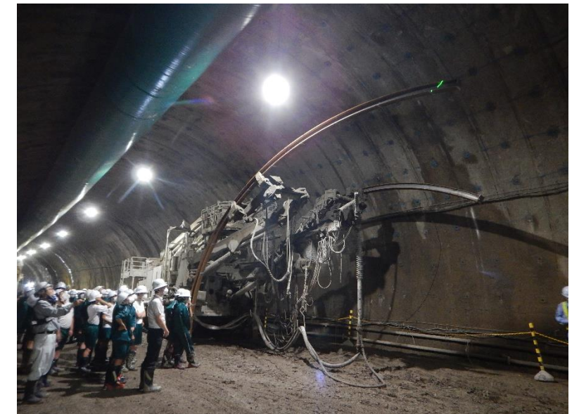
▲トンネル内施工機械見学
