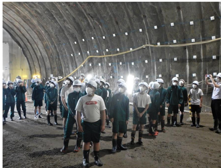
▲トンネル内見学状況
