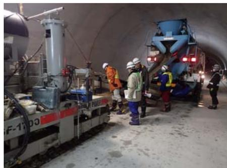
上院内トンネルは湯沢市上院内地内の延長 1,585m のトンネルで、現在の舗装工事はスリップフォーム工法による連続鉄筋コンクリート舗装で 3 月完了予定です。舗装が終了しましたらトンネル設備工事を、平成 27 年度から実施予定です。
