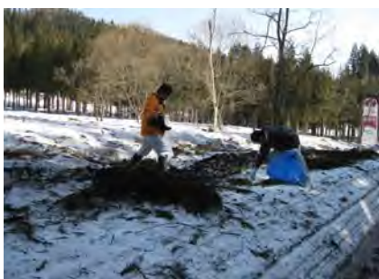
県境付近は、残雪の中の作業でした
