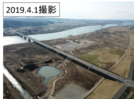
樹木伐採完了後
