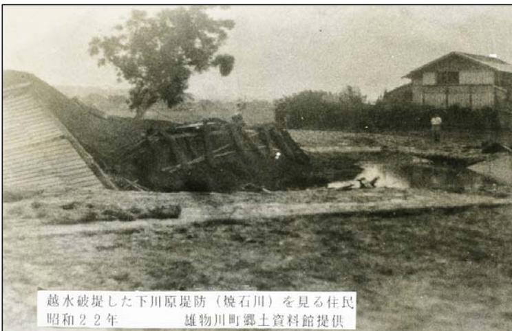
越水破堤した下川原堤防(焼石川)を見る住民(雄物川町)
