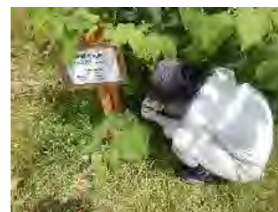
作業状況 (注入)
