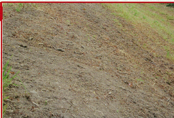
(写真1)除草後→裸地化状況
