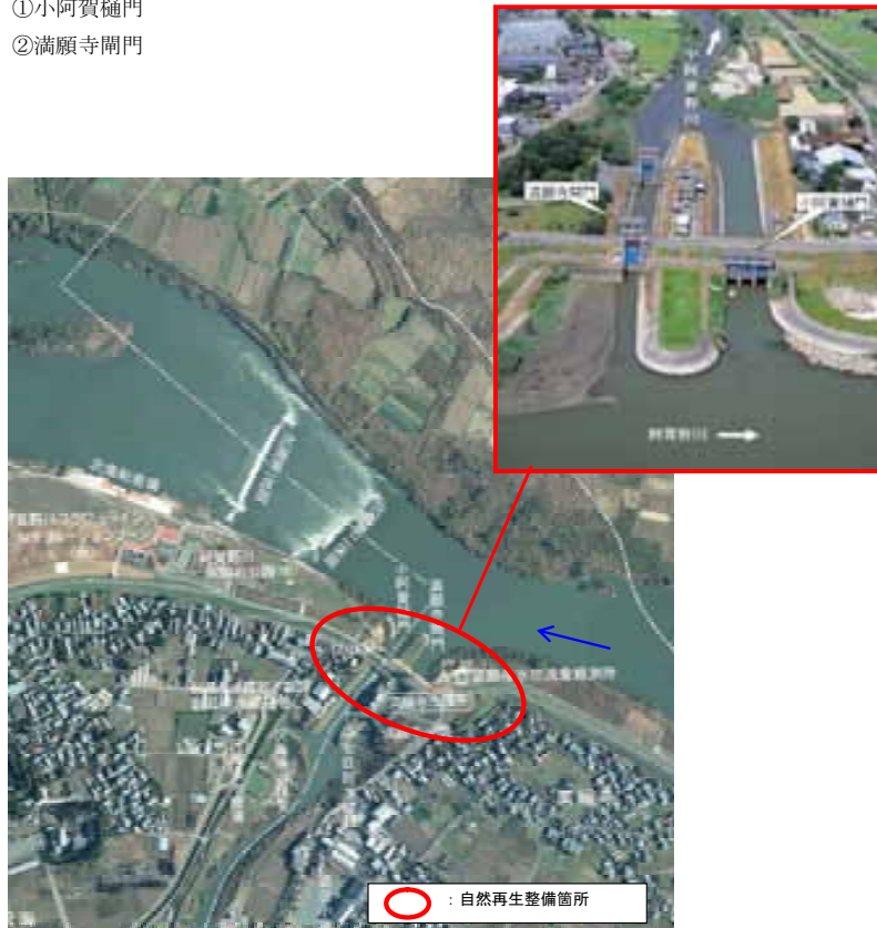
図 4.8-1 満願寺閘門と小阿賀樋門
