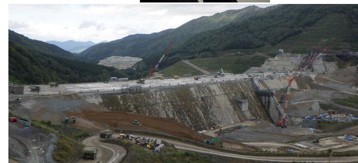
↑原石山展望台より堤体上流面を望む (堤体積の約8割まで進捗：R5.9末)
