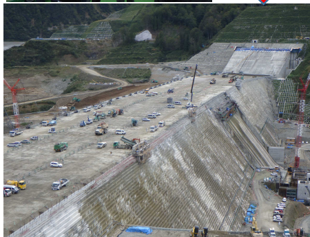
↑右岸展望台より堤体下流面を望む (世界最先端の自動化施工を実現している成瀬ダム堤体打設状況)
