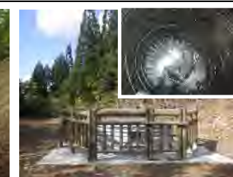
地すべり防止工
