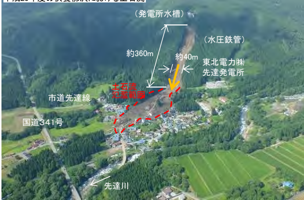
平成25年度の供養佛況における土石流
