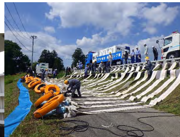
↑ 排水ポンプ設置状況
