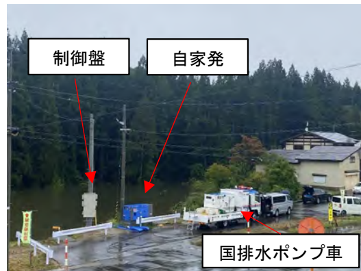
協和・小平沢排水樋門
