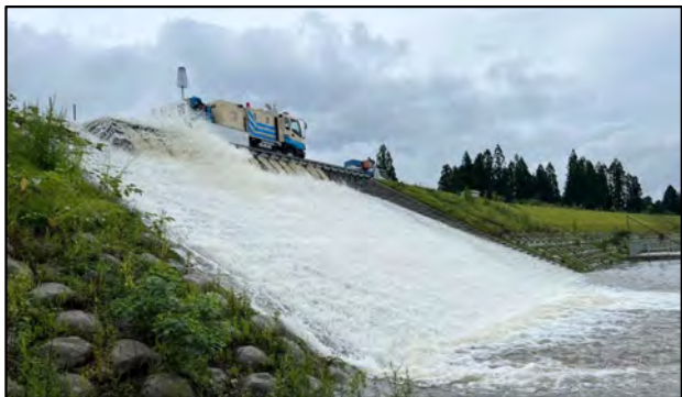
令和5年7月19日 西仙北・大佐沢樋門
