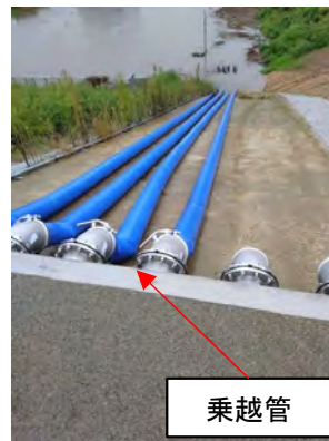
西仙北・大沢川樋門
