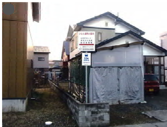
標識に設置した例（湯沢市）
