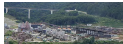
↑ 仮設備ヤード
