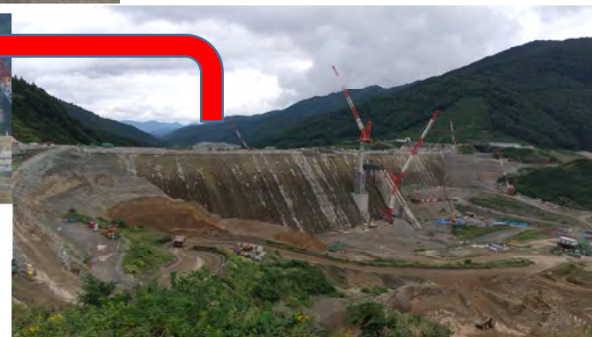
↑ 原石山展望台より堤体上流面を望む (ダム堤体施工状況)
